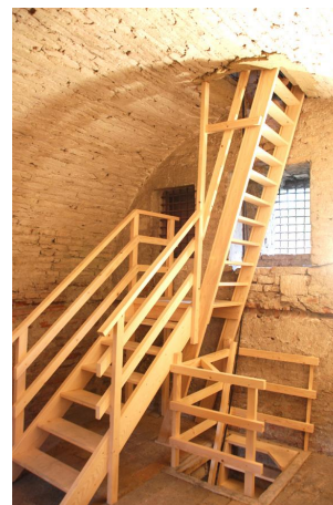
Treppe vom 1. ins 2.OG
